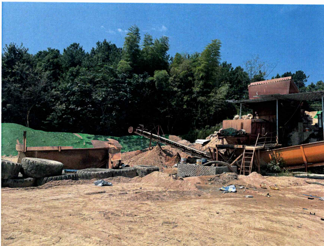
大坪乡沙口村下畈大桥上游砂场整改前
