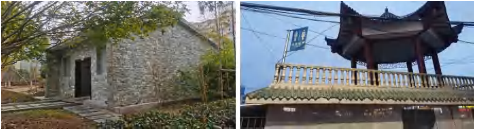
老城区现状公共厕所
