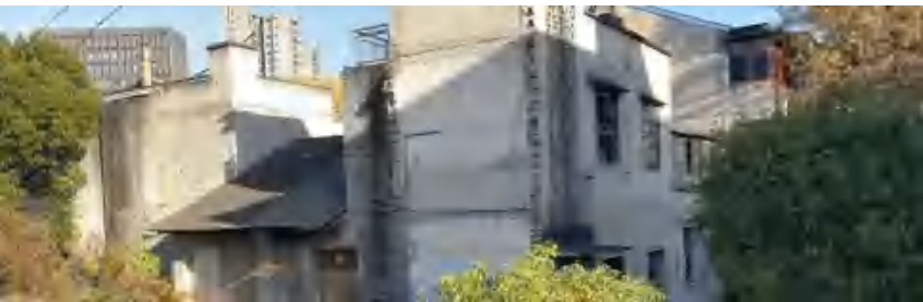
现状建筑外立面
