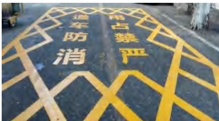
补齐消防通道施划线
