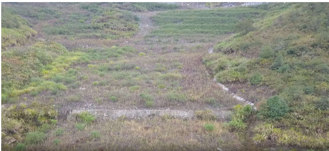
已完成生态修复的排土场
